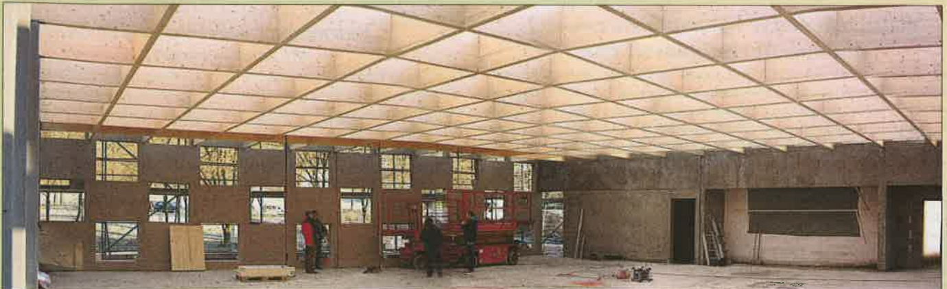
Innenansicht des fertig montierten Dachtragwerks
