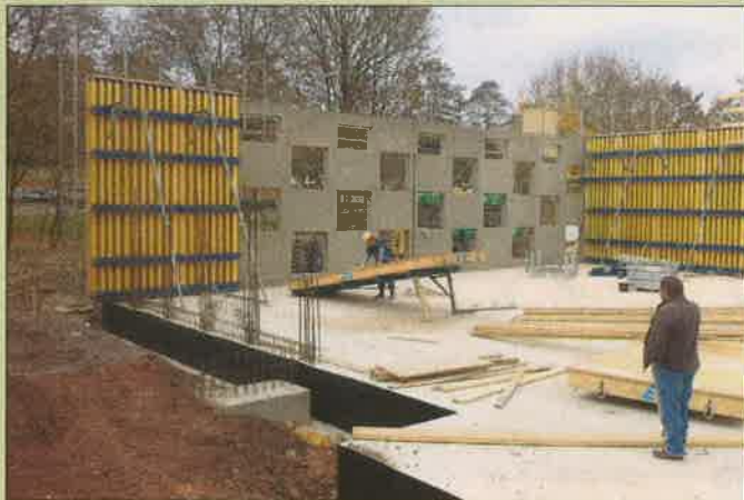
Ausschalen der fertig gestellten Wand
