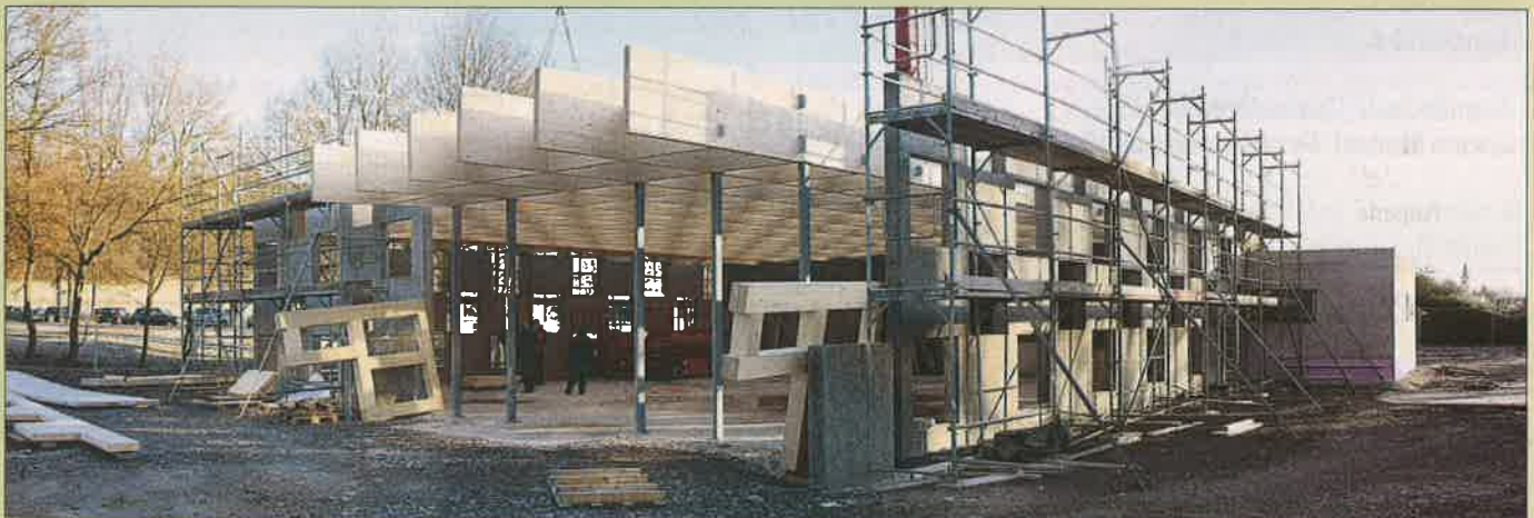
Eingangsseite mit austragenden Trägern über dem späteren Eingang
