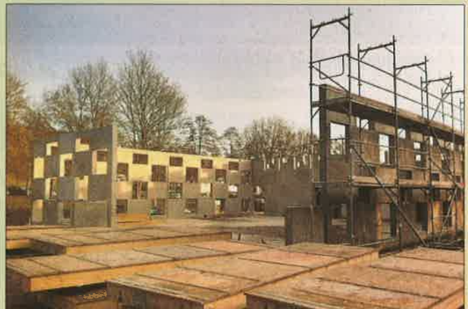
Fertig gestellte Betonwände mit Schalplatten im Vordergrund
